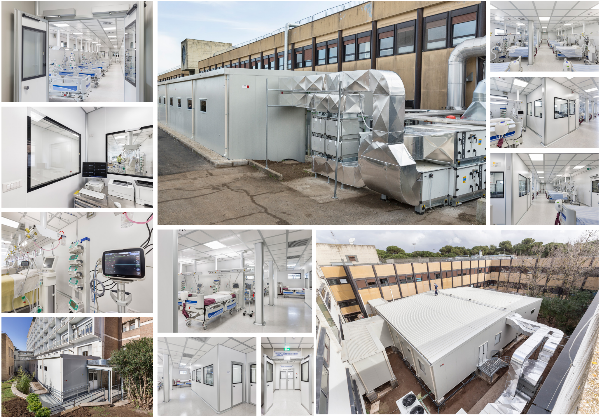
Nella foto Mangini Prefabricated Modular Hospital Febbraio 2021: Ospedale S. Pertini di Roma, Ospedale San Giovanni Addolorata di Roma, Ospedale G.B. Grassi di Ostia.
